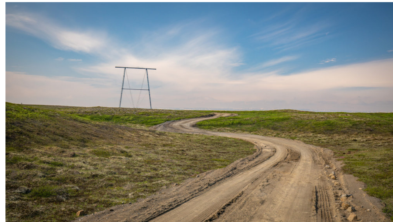
Dæmi 3. Nýleg línuslóð meðfram Hólasandslínu 3
