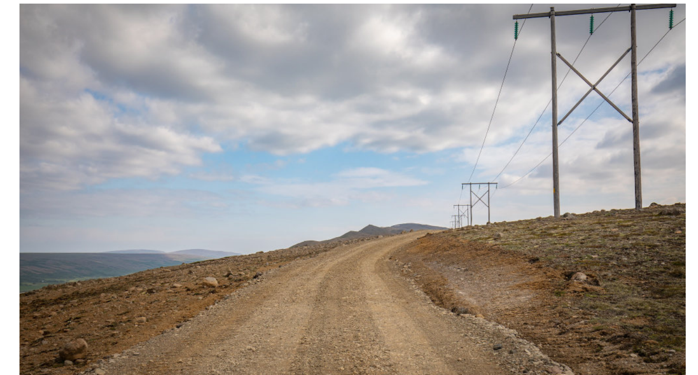
Dæmi 4. Nýleg línuslóð vegna Hólasandslínu 3
